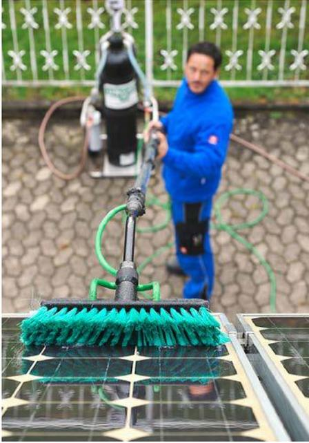
Bis zu 30% mehr Leistung durch eine regelmäßige und fachgerechte Reinigung mit aufbereitetem Wasser.
